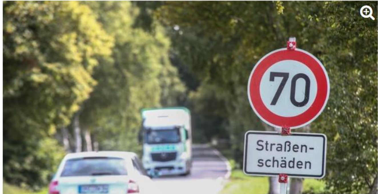
Der Landkreis Osterholz plant ein millionenschweres Sonderprogramm zur Sanierung der Kreisstraßen und Radwege. (Christian Kosak)
